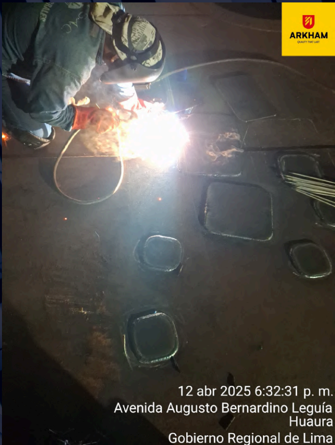
REPARACIÓN TANQUE API 653
