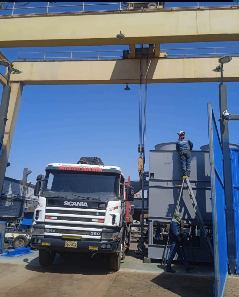
MONTAJE DE EQUIPOS INDUSTRIALES
