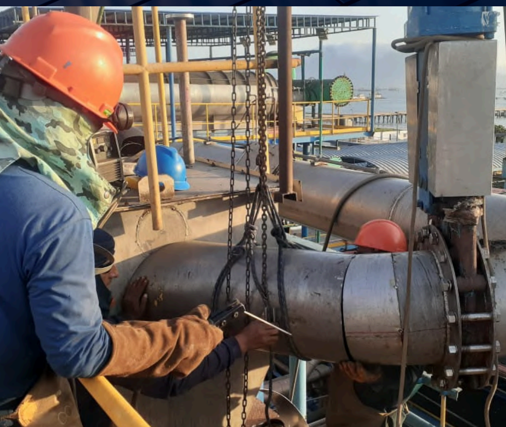
SOLDADURA DE TUBERÍA INOXIDABLE
