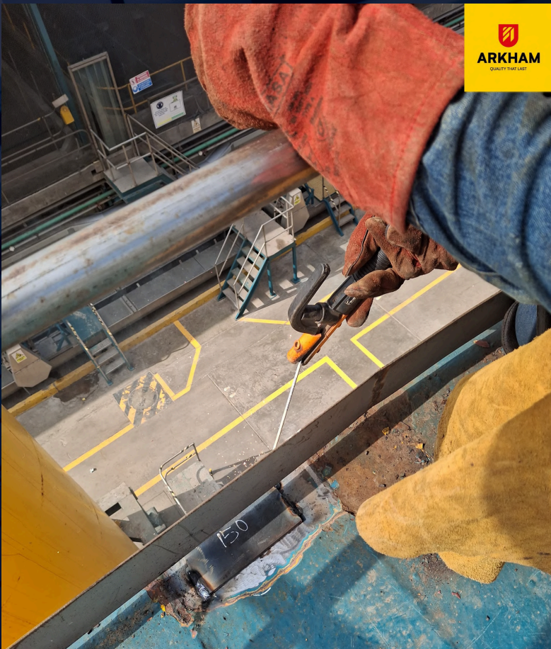
REPARACIÓN TANQUE API 653
