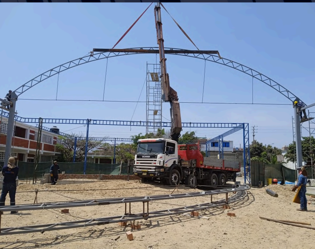
FABRICACIÓN Y MONTAJE TECHO METÁLICO
